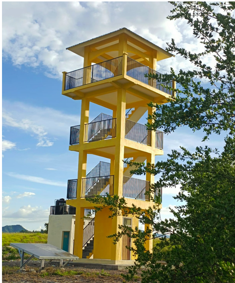
Gambar 1.A.25. Progress pembangunan menara pantau di Pulau Namo
