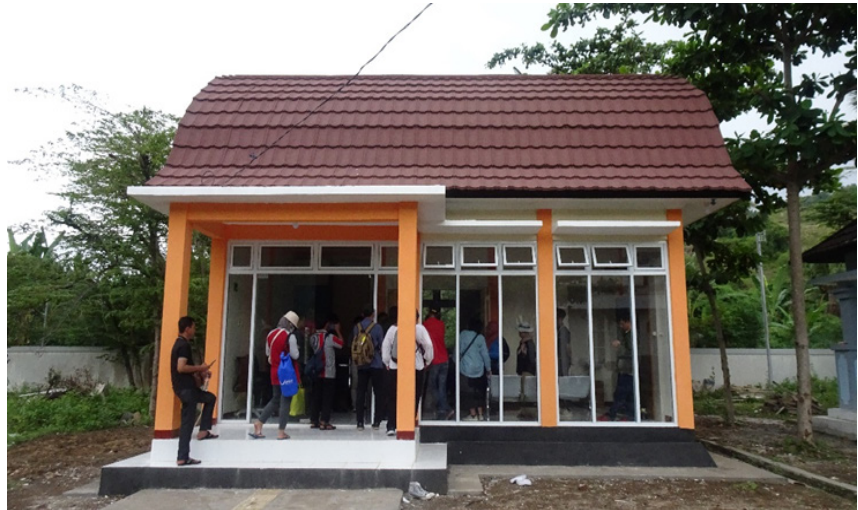
Gambar 1.A.10. Progress pembangunan Pusat Informasi GP2 di Teluk Nara, Lombok Utara
