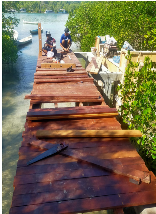
Gambar 1.A.21. Progress pembangunan mangrove tracking di Nusa Ceningan, Nusa Penida
