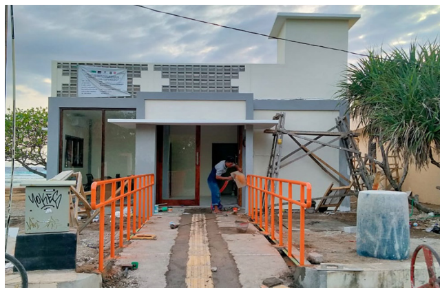
Gambar 1.A.24. Progress pembangunan post pengawasan di Gili Trawangan
