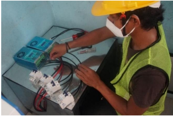
Instalasi Penambahan daya lemari pendingin Tenaga Surya di Kampung Mutus dan Sawandarek Raja Ampat, 2021
