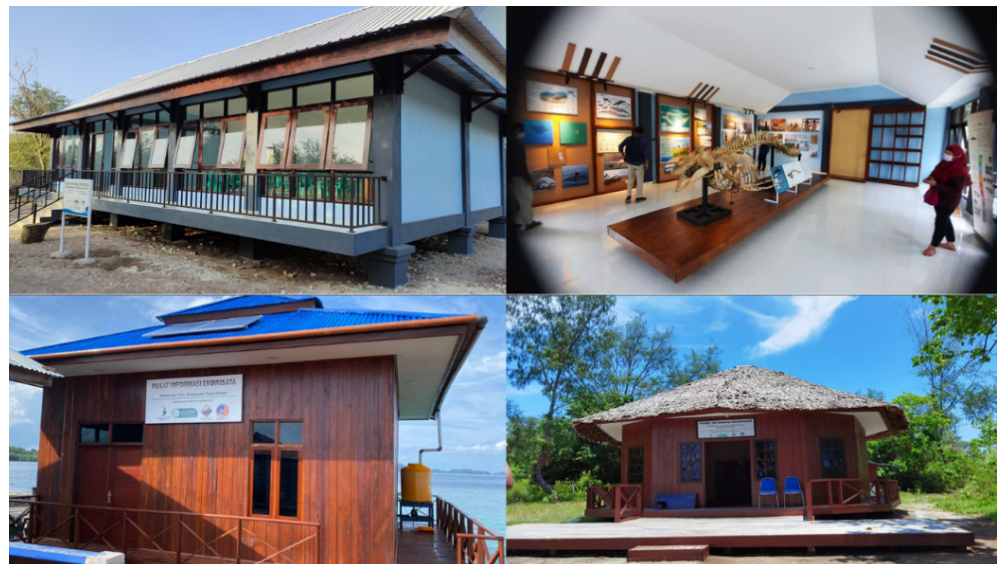
Gambar 5. Infrastruktur yang dibangun oleh penerima hibah. Kiri atas dan kanan: Pusat informasi di Oesina, Kupang; Kanan bawah: Pusat informasi di Yelu, Misool; Kanan bawah: Pusat informasi di Meosasar Kecil
