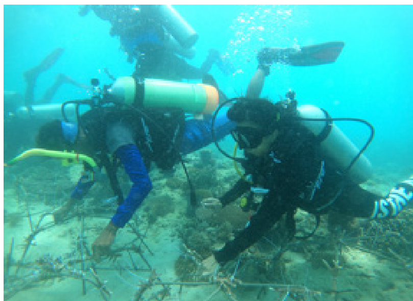
Gambar 1.A.9 Peletakan Spider Web
