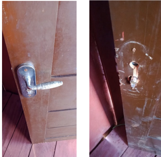
Gambar 1.A.2 Kerusakan pada pintu rumah jaga karena korosi
