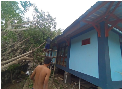
Gambar 1.A.1.3. Kerusakan PLTS akibat Badai Seroja di Nusa Manuk, Kab. Rote Ndao
