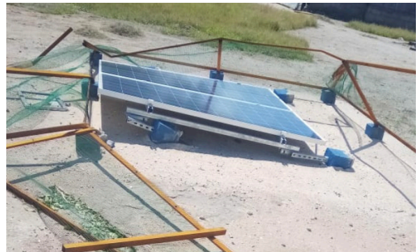
Gambar 1.A.1.4 Sebagian area Pusat Informasi Ekowisata di Sabu tertimpa pohon dan mengalami kerusakan ringan akibat badai Seroja
