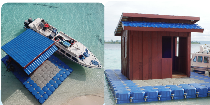
Stasiun Pemantauan Pari Manta & Hiu di Pulau Yef Nabi Kecil, Papua Barat
