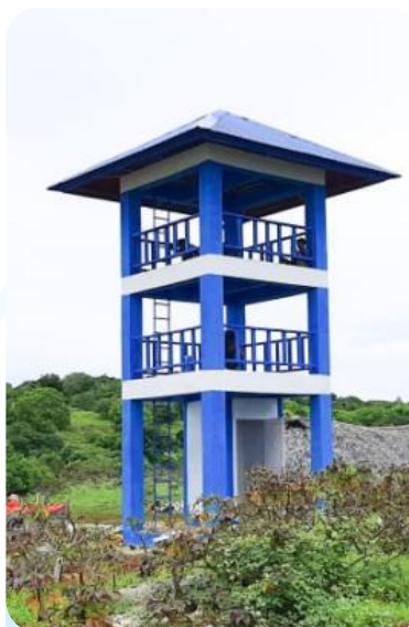
Kondisi Menara Pokmaswas di Loborae, Pulau Sabu, Nusa Tenggara Timur
