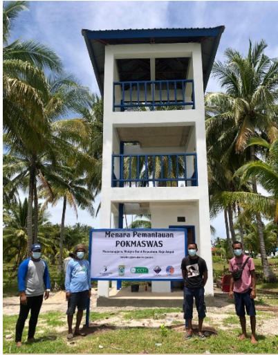
Menara Pengawas di Meosmanggara, SAP Raja Ampat sudah selesai 100%
