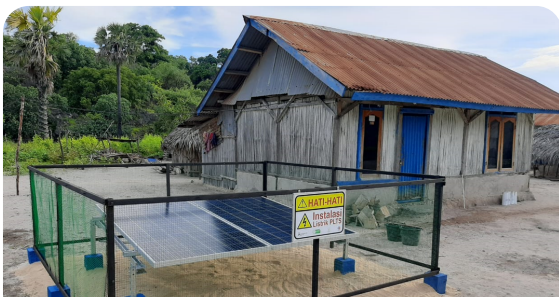
Instalasi Panel Surya di Nusa Manuk
