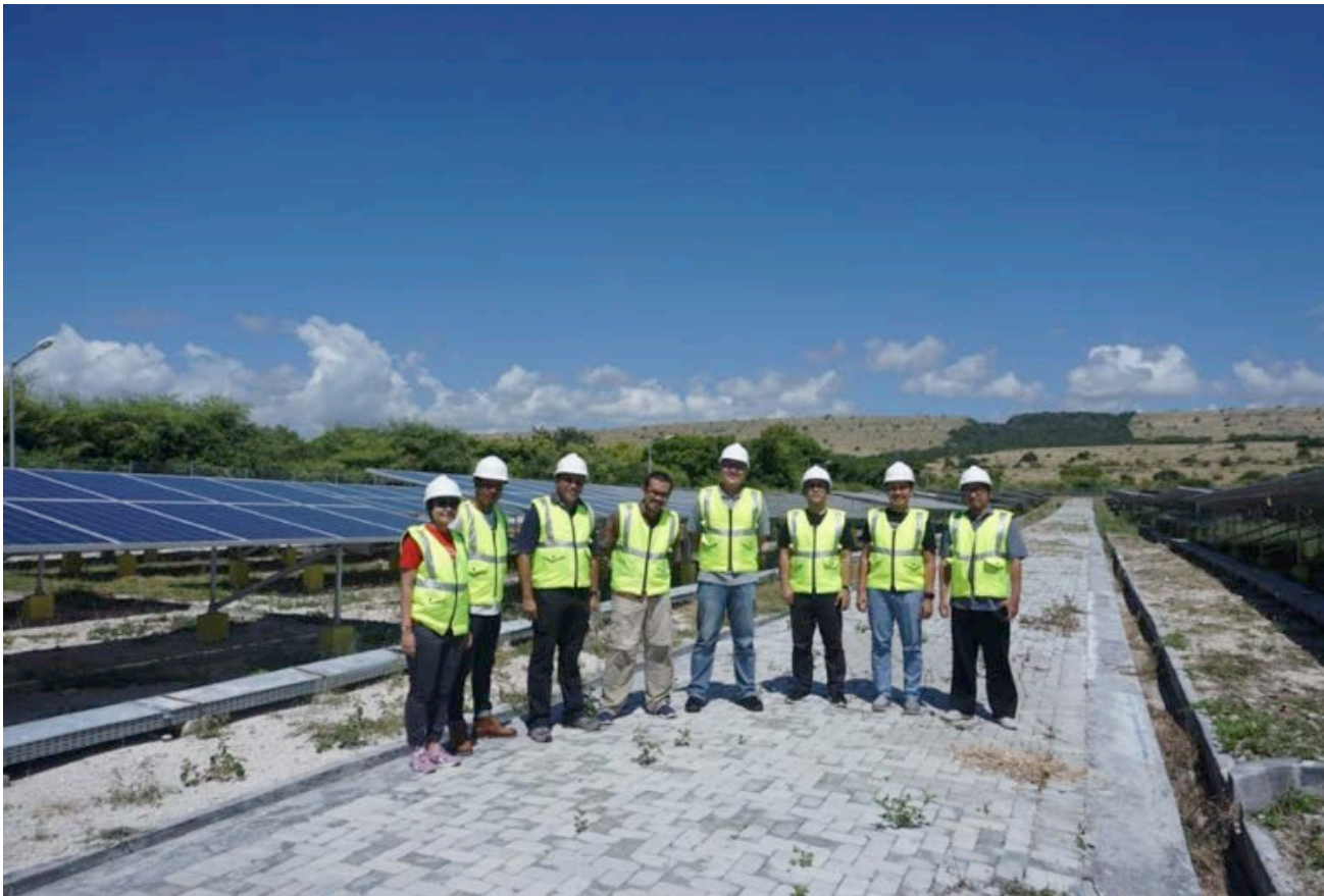
PLTS Hambapraing di Kabupaten Sumba Timur dengan Kapasitas 1 MW.
