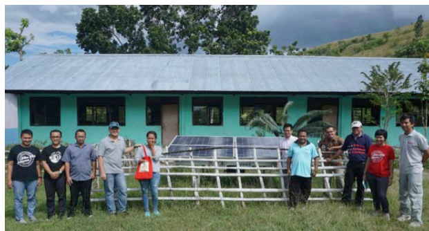
Meninjau Pemasangan Solar PV di Sekolah Dasar Masehi (SDM) Mbatakapidu Kabupaten Sumba Timur.
