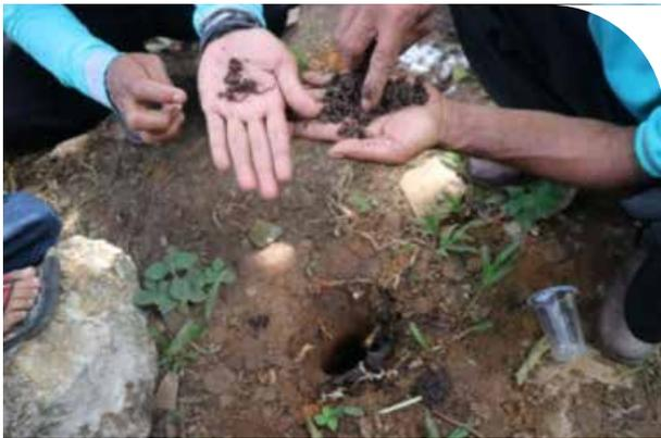
Pembuatan lubang biopori dengan menambahkan cacing untuk membentuk rongga tanah.
