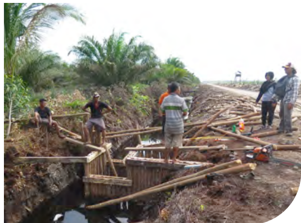
Lokasi pembuatan Sekat kanal di Desa Mundam.
