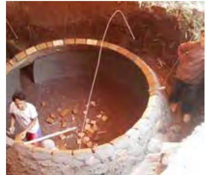
Proses konstruksi biodigester .
