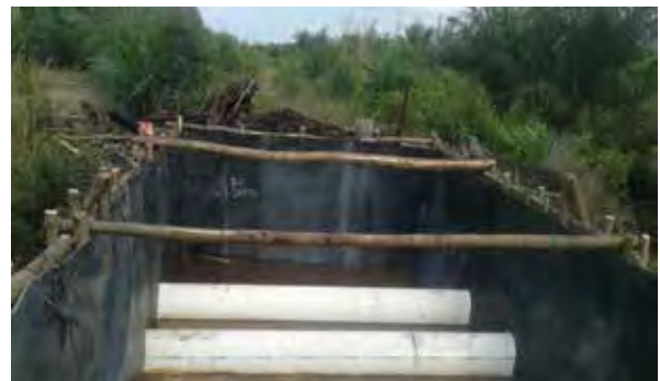
Kanal yg telah selesai dibangun.
