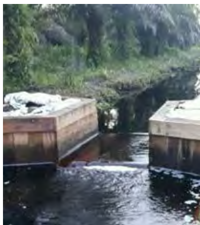
Sekat kanal di lokasi proyek KRG Jambi.
