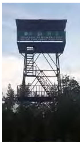
Menara pantau yang dibangun untuk pemantauan pencegahan karhutla yang merupakan bantuan dari ICCTF.
