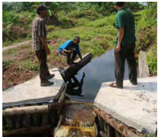
Pemeriksaan sekat kanal sebagai bagian dari monitoring yang dilakukan masyarakat.
