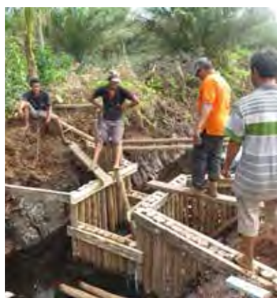
Pembangunan sekat kanal di lokasi proyek.
