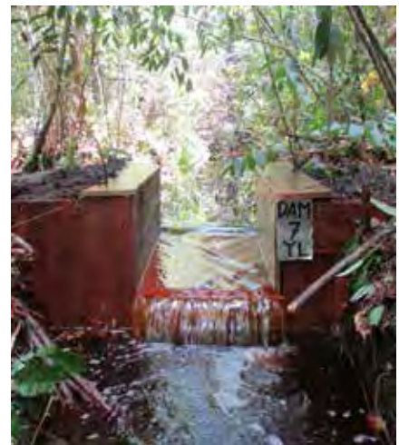
Pembangunan DAM yang merupakan kegiatan rewetting di kawasan gambut.
