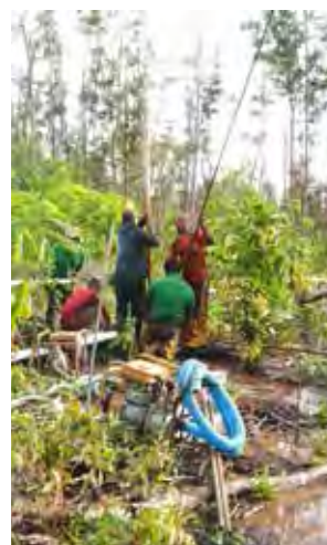
Pembuatan sumur bor.
