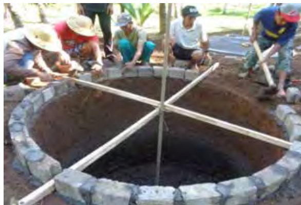
Pembangunan bak penampungan air.
