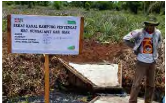
Sekat kanal di Kampung Penyengat sebagai bentuk kegiatan Rewetting .
